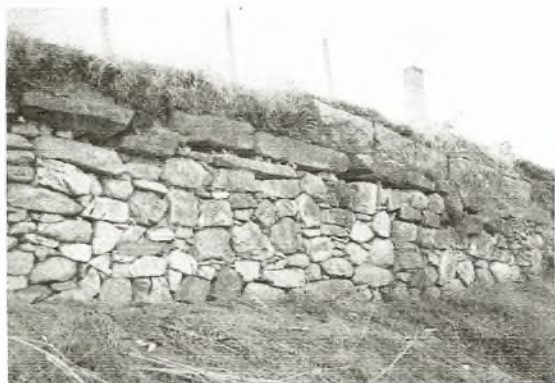
86. Φερές. Τμήμα τείχους πάνω στο λόφο «Καστράκι». Άποψη από ΒΑ
