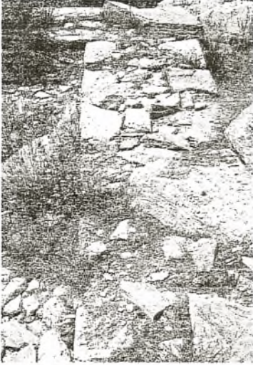
100. Σωρός. Άποψη πύργου
