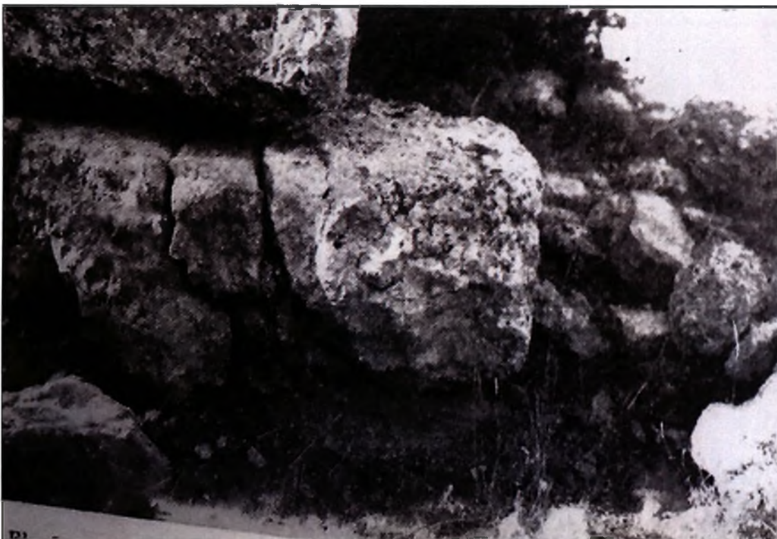
Εικόνα 19. Λεπτομέρεια της θεμελίωσης του βόρειου τείχους
