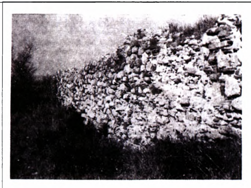
Εικόνα 17. Τμήμα τείχους που πιθανόν να ανήκει στην αρχαία Ηιών.
