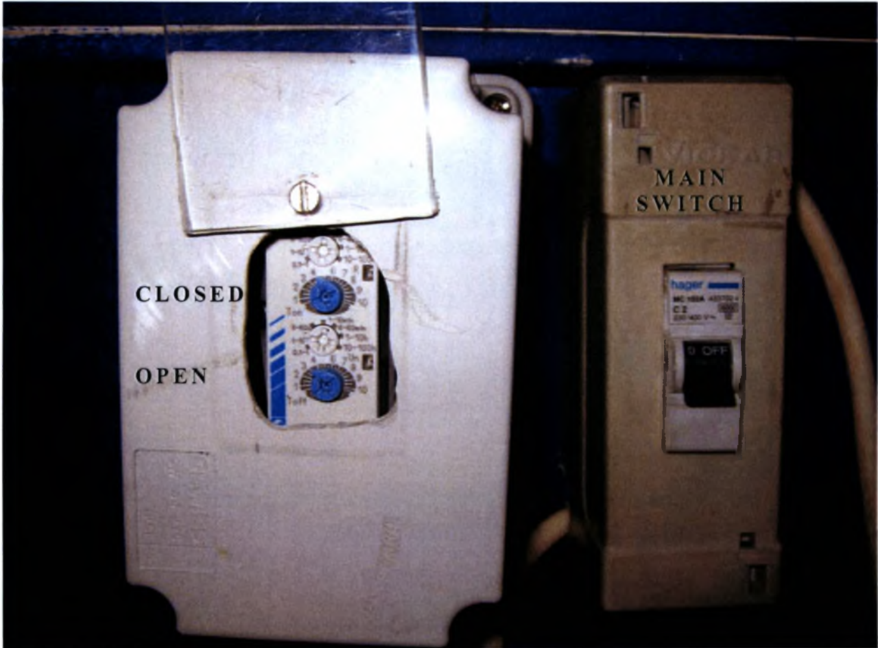
Σχήμα 3.11: Ο χρονιστής του συστήματος διαταραχής (αριστερά) και ο γενικός διακόπτης (δεξιά)
