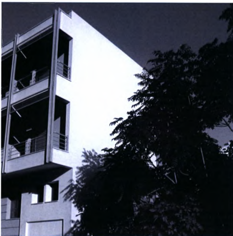
Σημείο 1/ Δίκτυο # 1/ 2ας Νοεμβρίου & Καποδιστρίου
