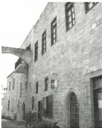
Εικ.9. Ντόπιος πωρόλιθος και ισόδομος τρόπος δόμησης
