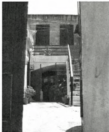
Εικ.10. Καμαροσκέπαστες αποθήκες στο ισόγειο και χώροι παραμονής στον όροφο
