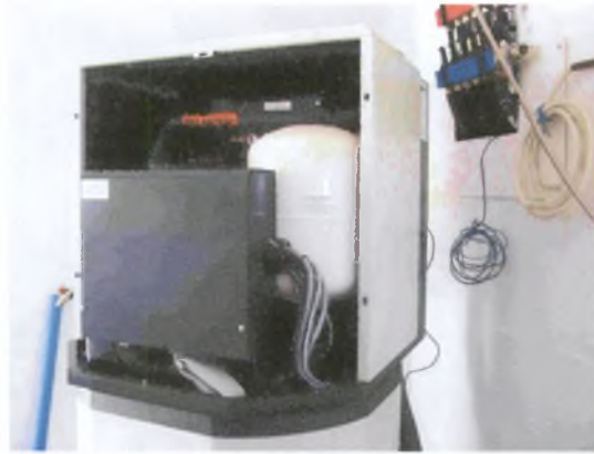
Σχήμα 7.9: Το εσωτερικό μιας αντλίας θερμότητας (διακρίνεται η δεξαμενή αποθήκευσης ζεστού νερού)
