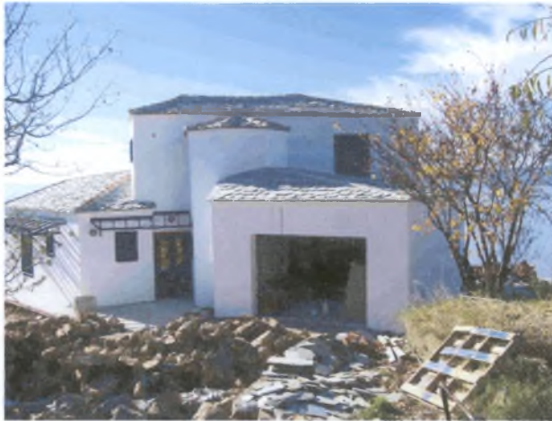
Σχήμα 7.10 Εξοχική κατοικία στην οποία εγκαταστάθηκε το σύστημα ΓΑΘ
