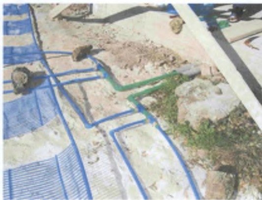
Σχήμα 7.3: (α)κεντρικός σωλήνας ένωσης των πλεγμάτων, (β) και (γ) λεπτομέρεια των ενώσεων με τις κεντρικές εισαγωγής, (δ)κεντρικές εισαγωγές και εξαγωγές μέσα στο κτίριο
