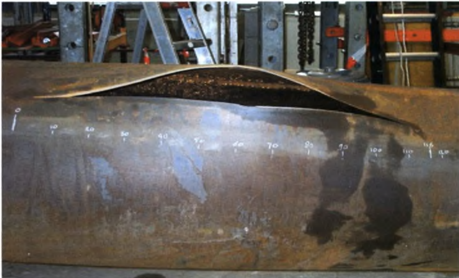
Σχήμα 2.10 Αστοχία αγωγού, στο 3 ο πείραμα.
