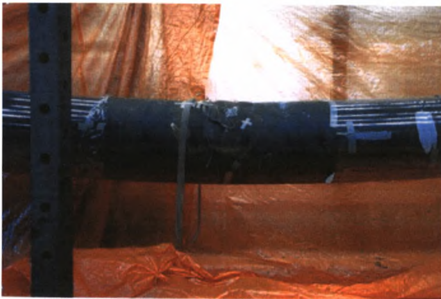
Σχήμα 2.11 Αγωγός υπό εσωτερική πίεση 100 bar, στο 3 ο πείραμα.
