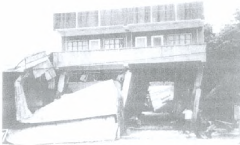
Εικόνα 1.2. 1 Μηχανισμός μαλακού ορόφου, σεισμός Φιλιππίνων 1990 (EQE Engineering Inc)
