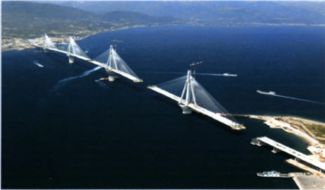
Φωτογραφία 4.1 Άποψη γέφυρας κατά την φάση κατασκευής.
