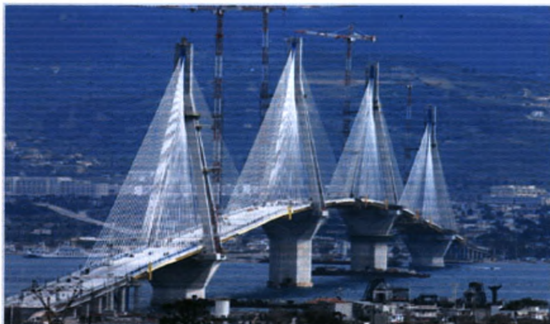
Φωτογραφία 4.3 Γέφυρα Ρίου-Αντιρρίου λίγο πριν την ολοκλήρωσή της κατασκευής
