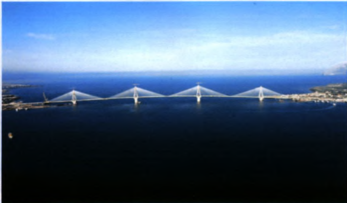
Φωτογραφία 4.2 Γέφυρα Ρίου-Αντιρρίου
