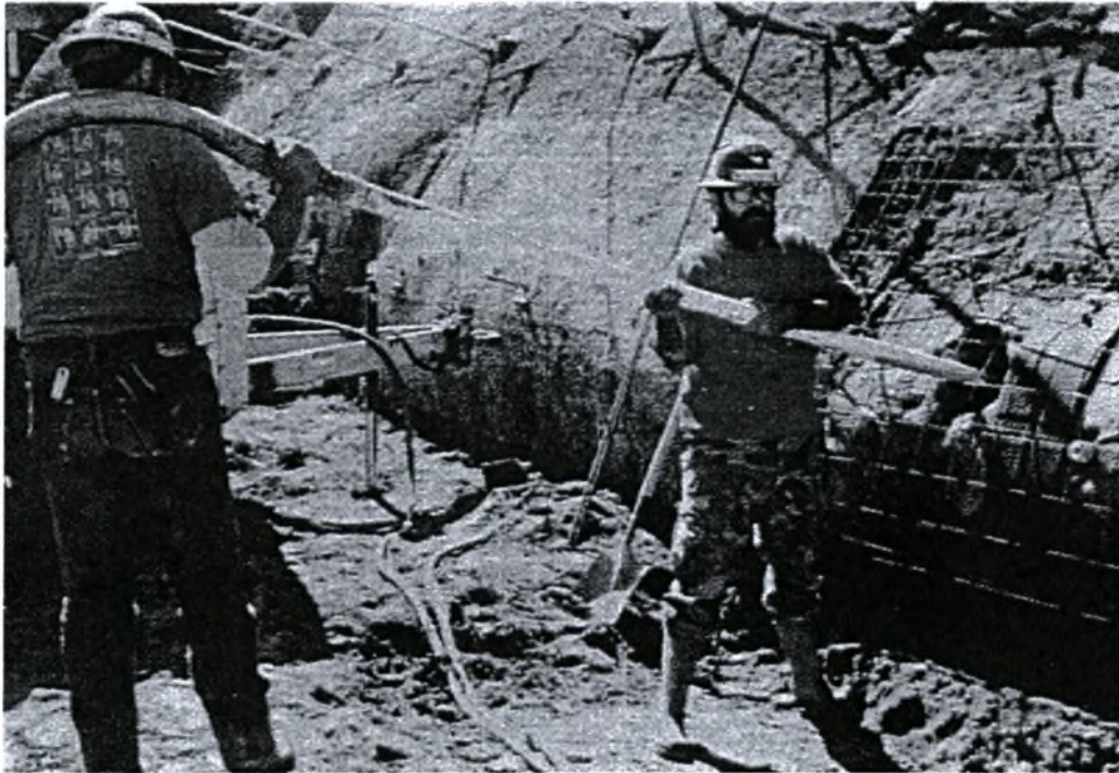
Εικ. 1.1 : Έγχυση τσιμεντενέματος διά μέσου της οπής (Porterfield et al., 1994).
