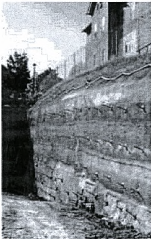
Εικ. 1.10: Ενίσχυση μετώπου εκσκαφής δίπλα σε υφιστάμενη κατασκευή.
