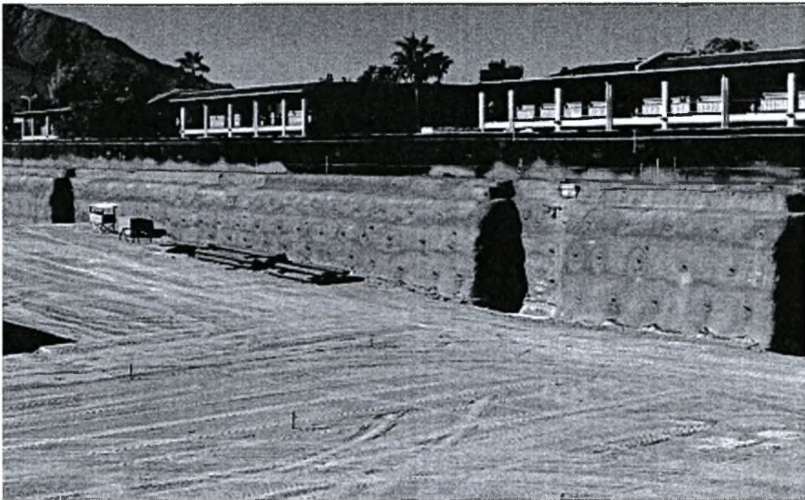
Εικ. 1.8: Υποστήριξη μετώπου εκσκαφής παραπλεύρως υφιστάμενων κατασκευών.
