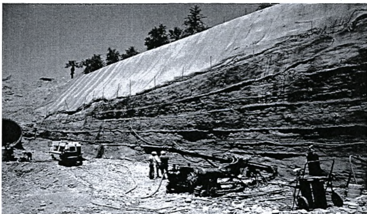
Εικ. 1.13: Σταθεροποίηση εδαφικής ζώνης που υπέρκειται βραχώδους στρώματος.
