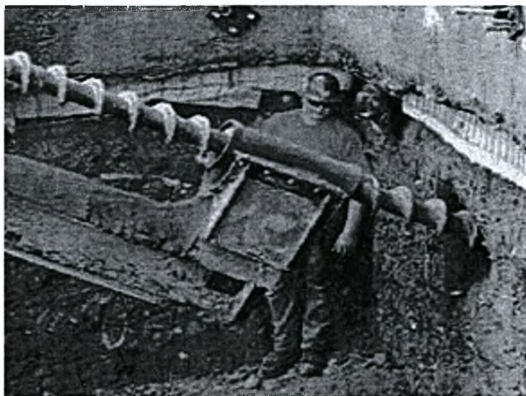
Εικ. 2.2: Διάνοξη οπής με ελικοφόρο τρυπάνι (auger).
