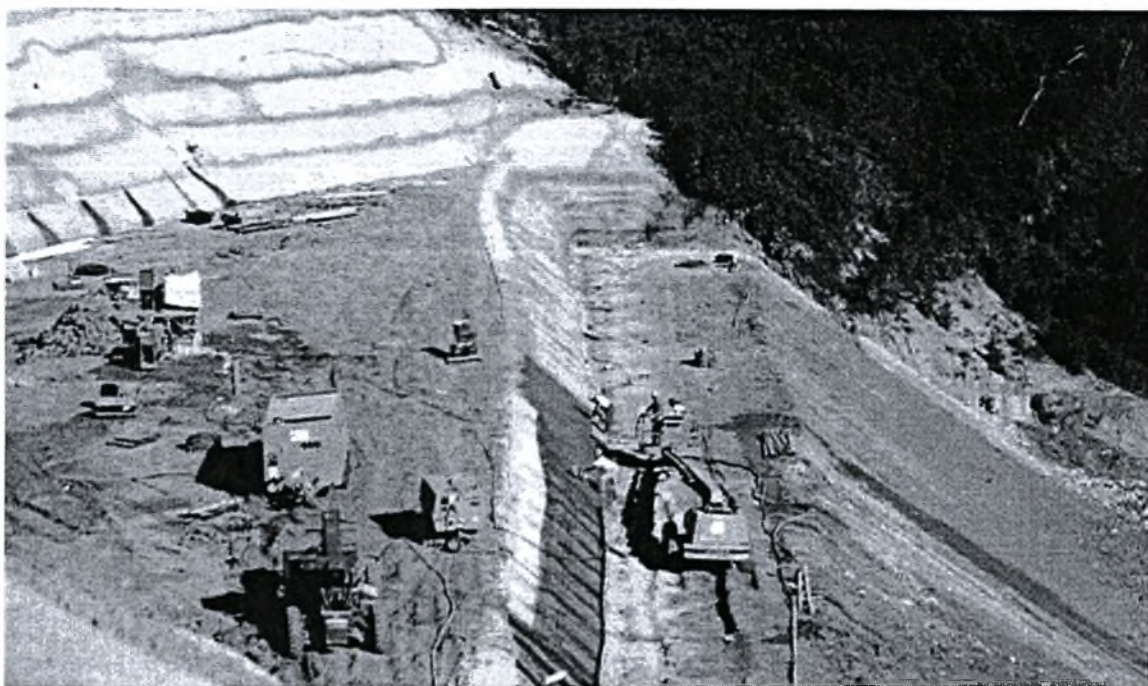
Εικ. 1.12: Λεπτομέρεια της εικόνας 1.11, όπου διακρίνονται οι σχετικοί αναβαθμοί που βοηθούν στην ευστάθεια και παρέχουν πρόσβαση στα συνεργεία.
