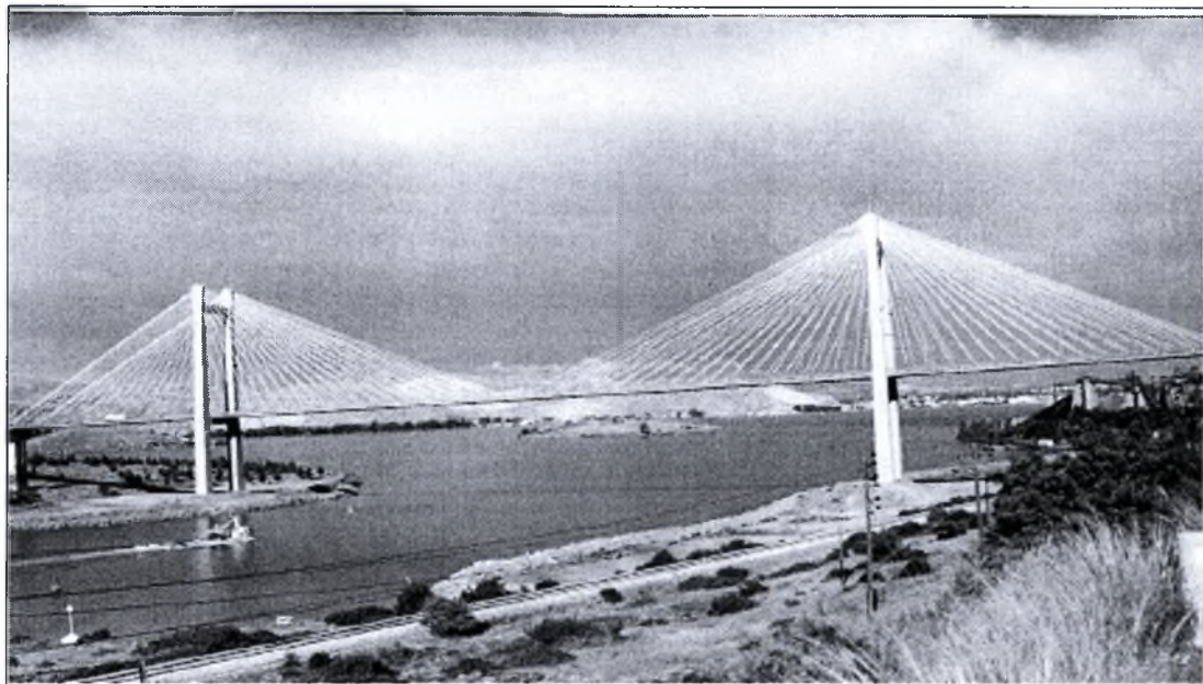
Σχήμα 1.16: Η γέφυρα της Χαλκίδας
