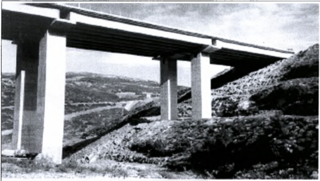
Σχήμα 1.1: Η γέφυρα της Καβάλας
