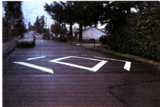
Φωτ. Speed hump
