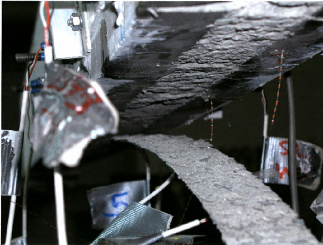
Σχήμα 3.24 Αποκόλληση του FRP κοντά στο μέσο του ανοίγματος.
