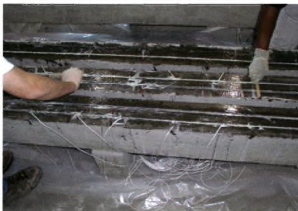
Σχήμα 3.13 Απομάκρυνση περισσευούμενης ρητίνης
