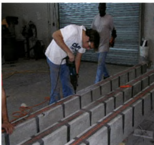
Σχήμα 3.14 κατασκευή οπών
