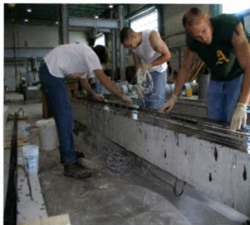
Σχήμα 3.12 Τοποθέτηση ελάσματος στις εγκοπές
