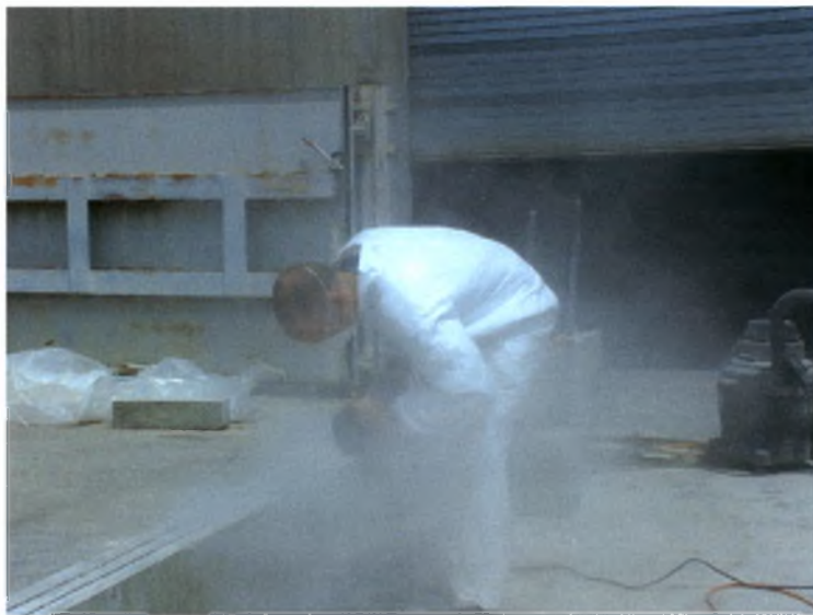
Σχήμα 3.10 Κατασκευή εγκοπών στο εφελκυσμένο πέγμα των δοκών
