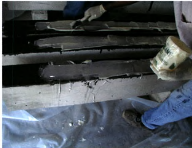
Σχήμα 3.6 Τοποθέτηση ρητίνης μετά την προετοιμασία της επιφάνειας
