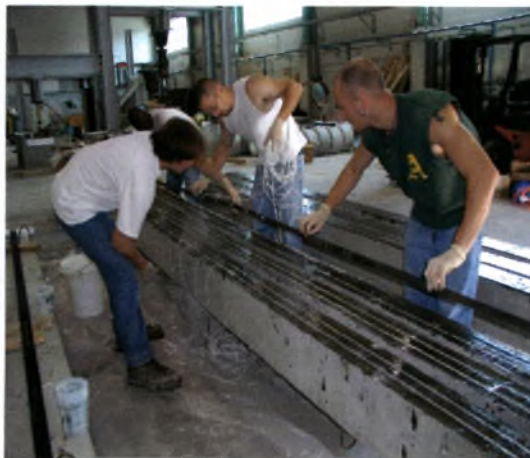
Σχήμα 3.12 Τοποθέτηση ελάσματος στις εγκοπές
