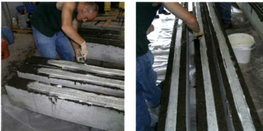
Σχήμα 3.9 Απομάκρυνση περισσευούμενης ρητίνης
