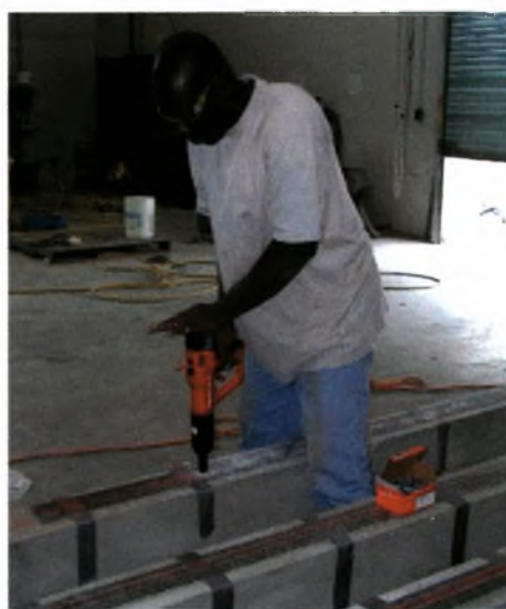
Σχήμα 3.15 Τοποθέτηση ήλων
