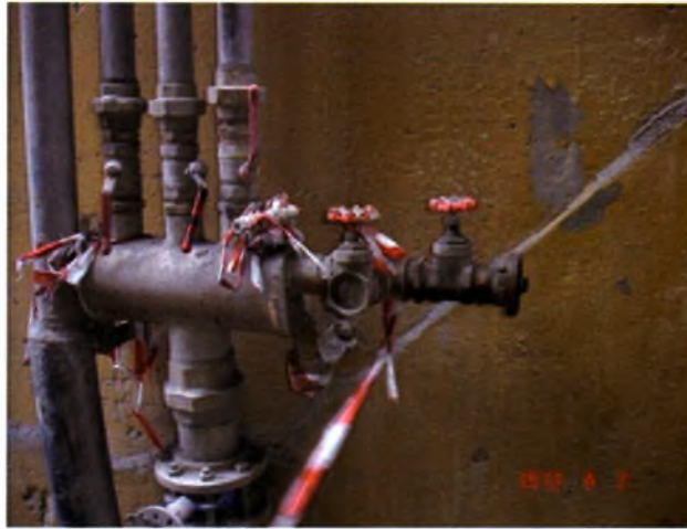
Εικόνα 41: Φωτογραφία του σημείου μέτρησης της θερμοκρασίας εισόδου του νερού στο κύκλωμα
