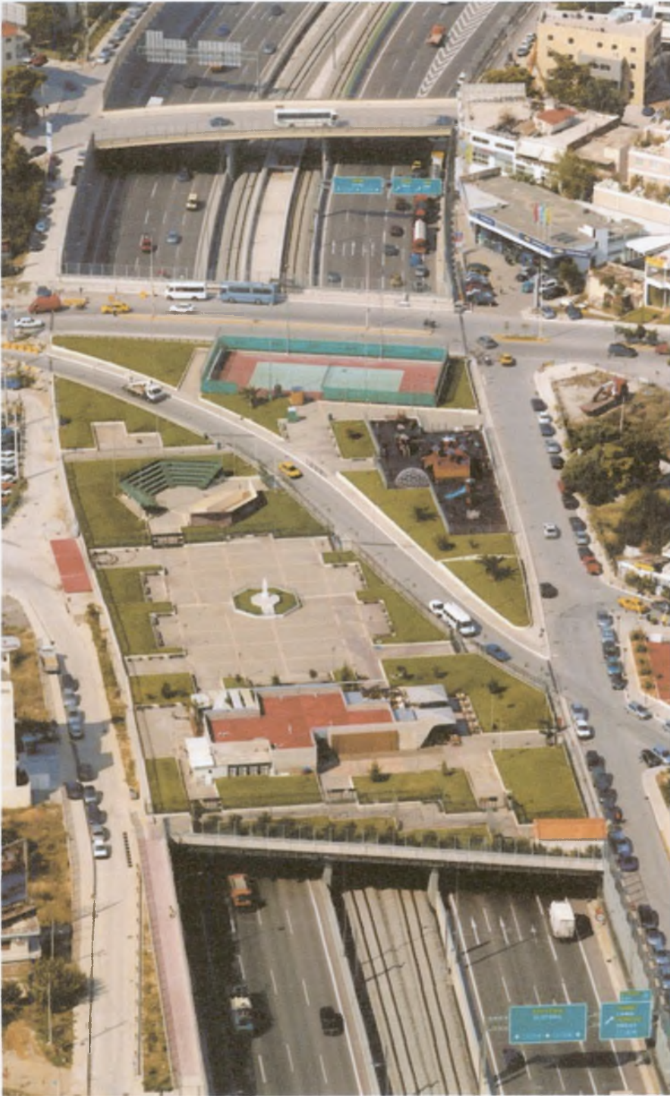
Σκεπαστό Σήραγγας Ηρακλείου
