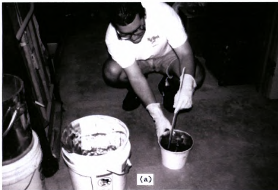
Εικόνα 3.6.1: Προετοιμασία κόλλας για την εφαρμογή των ΙΟΠ
