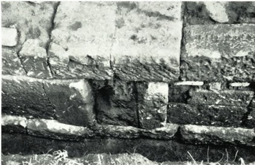
β. Ἐργὸς ἀποχετεύσεως ἐντὸς τοῦ παραθαλασίου τείχους. Στόμιον ἐσωτερικῆς πλευρῆς.
