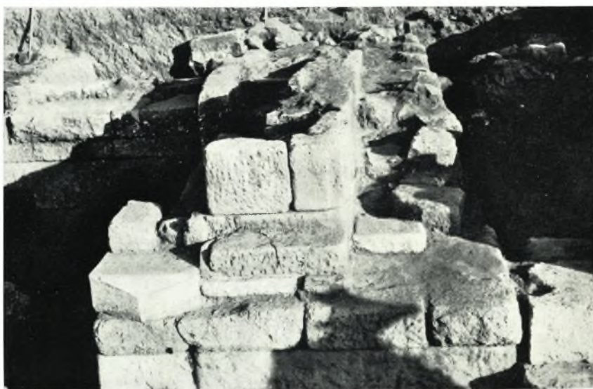
β. Λεπτομέρεια κατασκευῆς τοῦ τείχους βορείως τῆς δυτικῆς πύλης.
