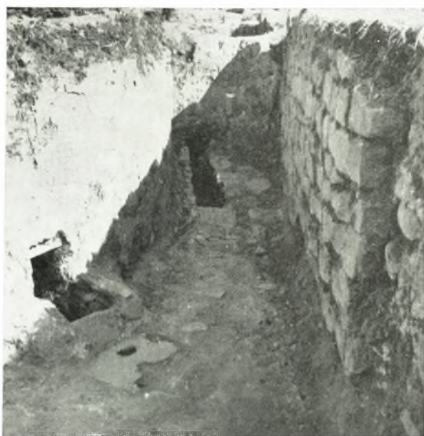
β. Ἀποχετευτικοὶ κτιστοὶ ἀγωγοὶ τοῦ λουτρῶνος.
