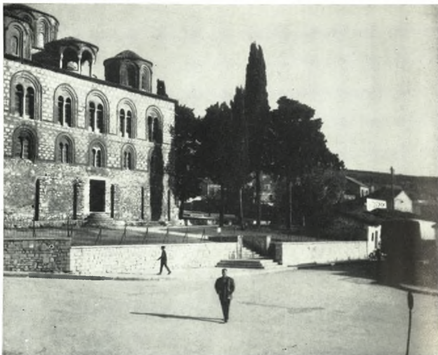
α. Ὁπίς τοῦ νέου περιβολοτοίχου τῆς Παρθορητίσσης ἀπὸ ΒΔ.
