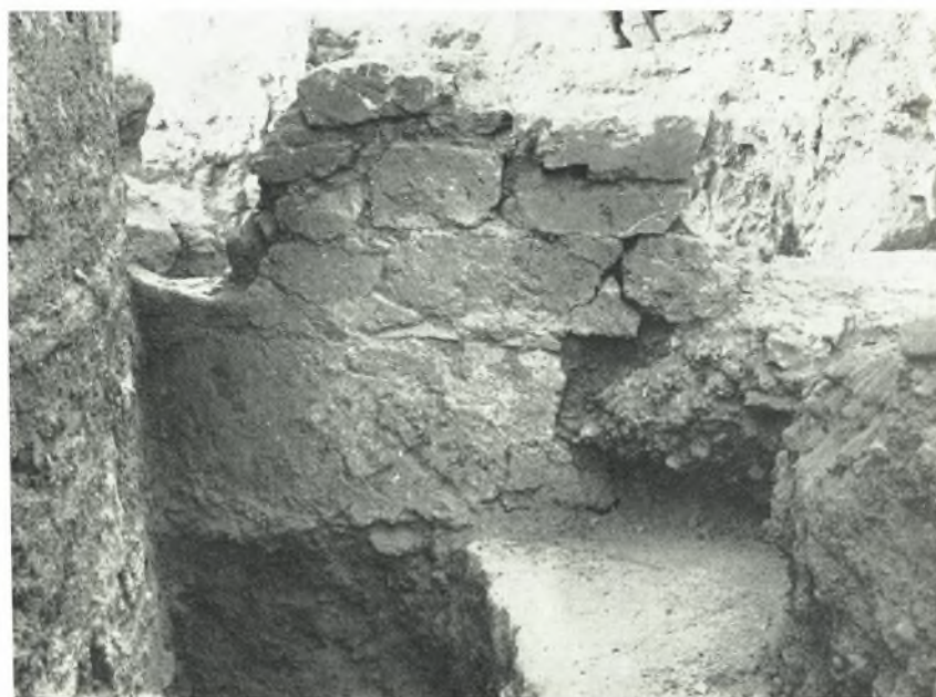
β. Ἐξωτερικὴ ὄψις τοῦ ἀνατολικοῦ τοῖχου τῆς ὀρθογωνίου δεξαμενῆς (ἀπὸ Α.).
