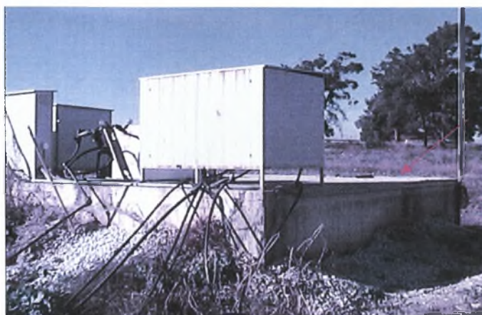
Εικόνα 4.8 Δεξαμενή συγκέντρωσης νερού άρδευσης.
