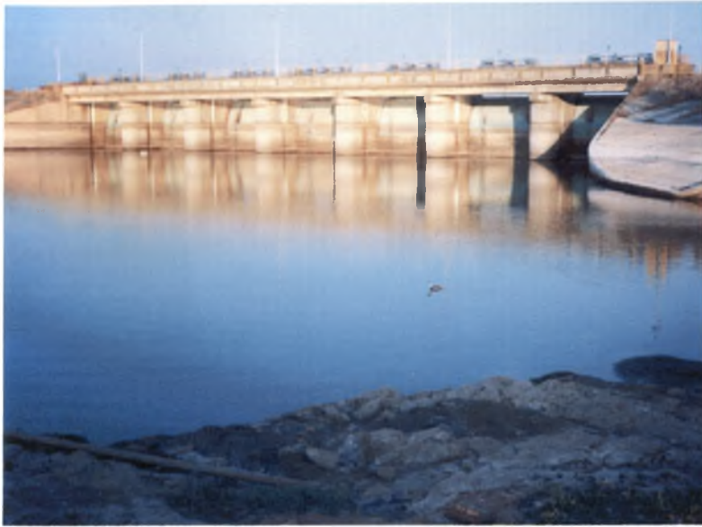
Φωτ.1: Άποψη του θυροφράγματος στη θέση Λιθότοπος
