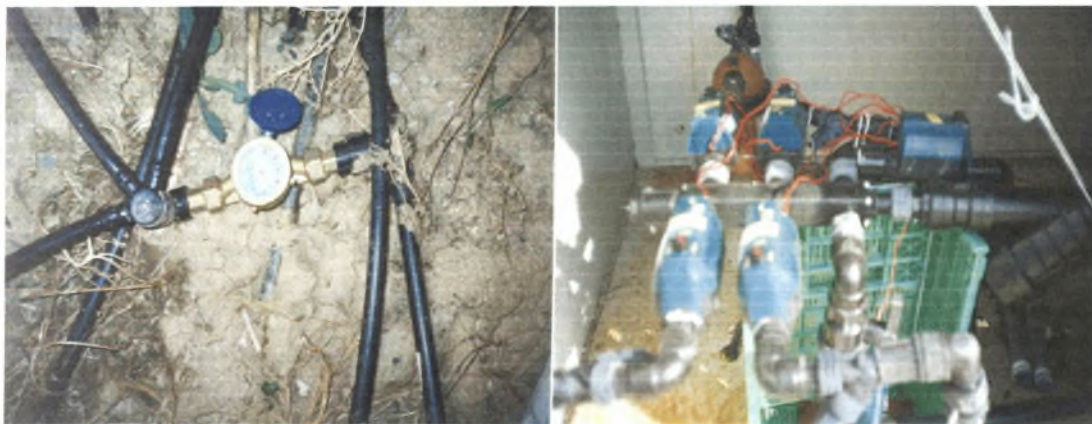
Εικόνα 5.6 Υδρόμετρο (α) και ηλεκτροβάνες (β).
