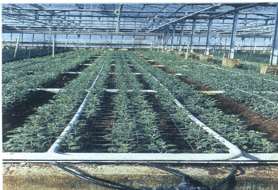
Εικόνα 1.12. Κεντρικό Σύστημα Θέρμανσης
