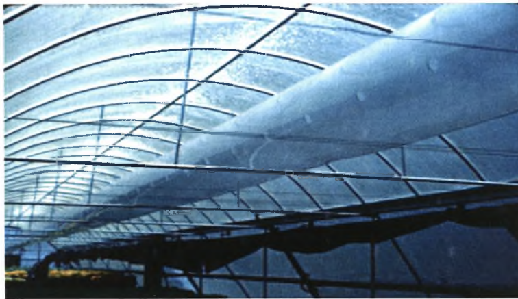
Εικόνα 1.9. Κατανομή θερμότητας στο θερμοκήπιο με τον διάτρητο πλαστικό σωλήνα
