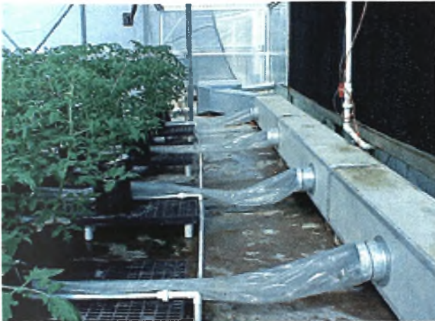
Εικόνα 1.8. Οι πλαστικοί διάτρητοι σωλήνες, που κατανέμουν το θερμό αέρα, μπορεί να βρίσκονται στο επίπεδο του εδάφους ή να κρέμονται από την οροφή, πάνω από το ύψος των φυτών
