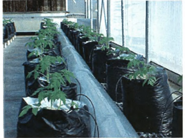
Εικόνα 1.8. Οι πλαστικοί διάτρητοι σωλήνες, που κατανέμουν το θερμό αέρα, μπορεί να βρίσκονται στο επίπεδο του εδάφους ή να κρέμονται από την οροφή, πάνω από το ύψος των φυτών
