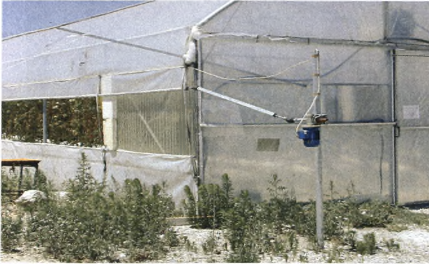
Εικόνα 3.2 Αποψη των πλαϊνών ανοιγμάτων του θερμοκηπίου που χρησιμοποιούνται για αερισμό.
