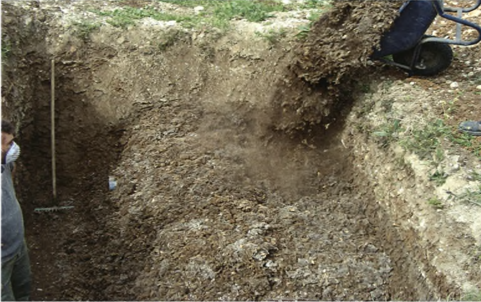
Εικόνα 4. Τάφρος τοποθέτησης των υποπροϊόντων εκκοκκιστηρίου.
