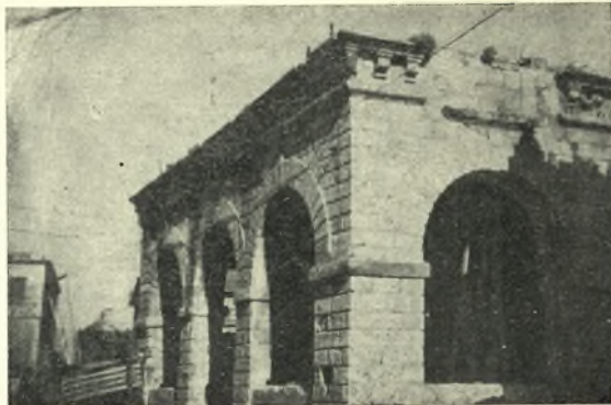
Εἰκ. 29. Ἔργασια ἀναστηλώσεως Ἐνετ. Λέσχης Ρεθύμνης.
