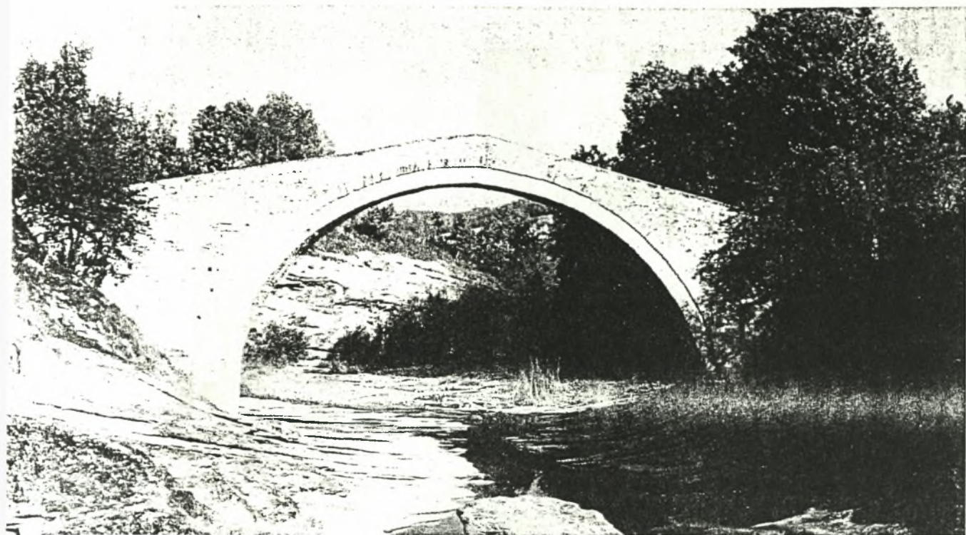
Η γέφυρα της Χρυσαιγής. Έργο των μαστοροκαλφάδων του Βοΐου, 19ου αιώνα. Έχει ύψος 9,8 μ. και άνοιγμα τόξου 14,5 μ.
