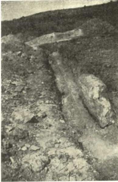
Εἰκ. 8. Τοιχοβάτης δυτικῆς πλευρᾶς κτηρίου ῥωμαϊκῆς ἐποχῆς.
