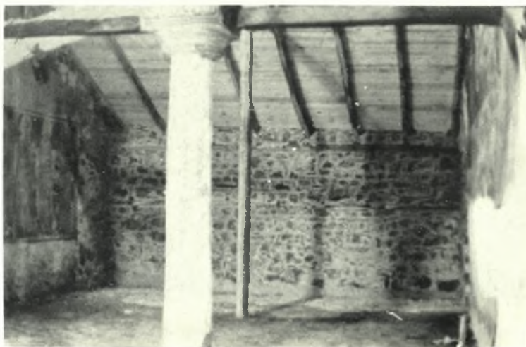
Μακεδονία. Βέροια: α. 'Ο ναός 'Αγίου 'Ιωάννου Θεολόγου μετά τās έργασίας ἀποκαταστάσεως, β - γ. 'Ο νότιος ἐξωτερικός τοίχος του 'Αγ. Γεωργίου πρό και μετά τήν ἀποκατάστασιν
