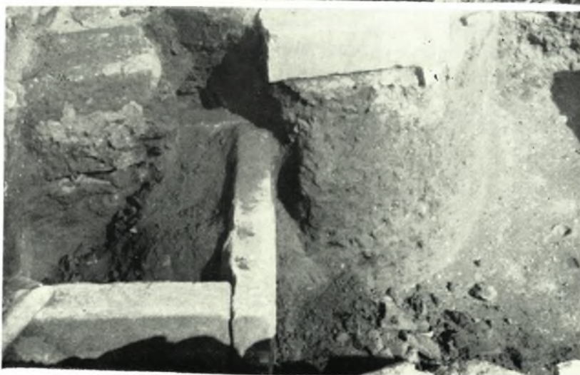
Ἄβδηρα: α. Τομεὺς ἀνασκαφῶν οἰκοδομῆς 4ου π.Χ. αἰῶνος, β. Ὁ τοῖχος τῆς προσόψεως τῆς οἰκοδομῆς καὶ ἐσωτερικῶς αὐτοῦ φρέαρ, γ. Τετράγωνος κατασκευὴ (ἔστια;) ἐντὸς τῆς οἰκοδομῆς
