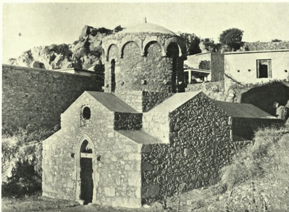
Κρήτη. Άξός Μυλοποτάμου. Ναός Ἁγίας Εἰρήνης: α. Ἐσωτερικὴ ὄψις νοτιοδυτικῆς γωνίας πρὸ τῶν ἐργασιῶν ἀναστηλώσεως, β. Ὁ ναὸς μετὰ τὴν ἀποκατάστασιν
