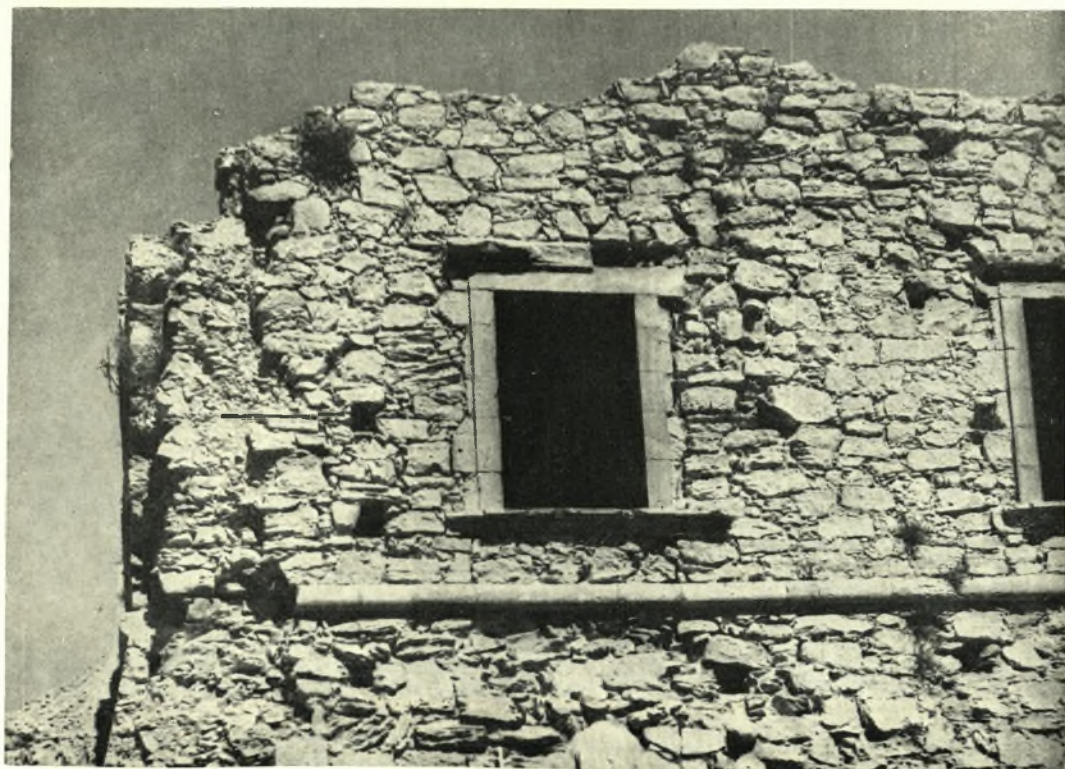
Κρήτη. Ἐτιὰ Σητείας: α - β. Ἐνατολικὴ ὄψις καὶ νοτιοανατολικὴ γωνία ἐπαύλεως τῶν Mezzo πρὸ τῶν ἀναστηλωτικῶν ἐργασιῶν
