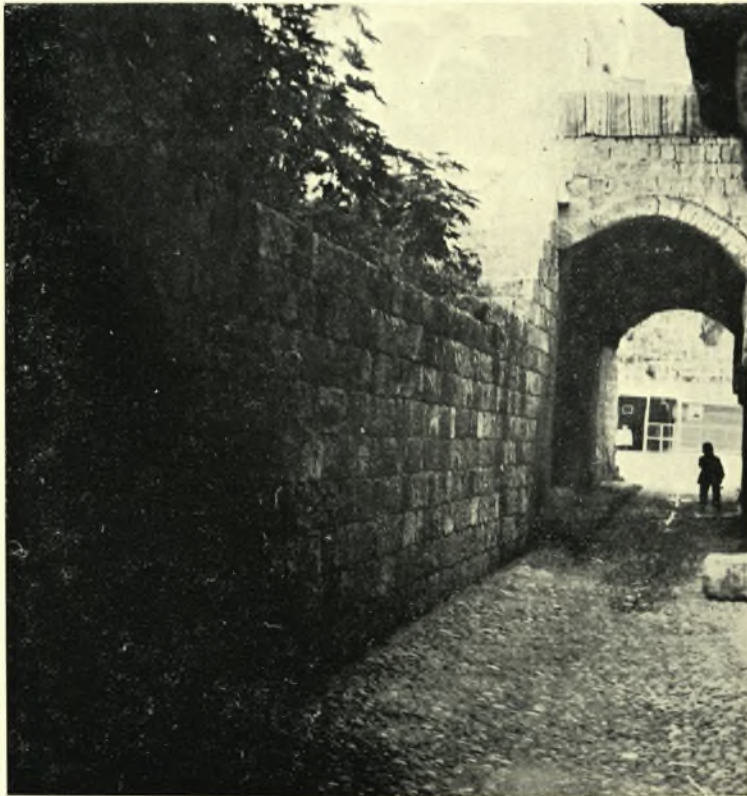
Ρόδος: α - β. Πάροδος Σοφοκλέους. Ό αναλημματικός τοίχος πρό και μετά την επίσκευήν του
