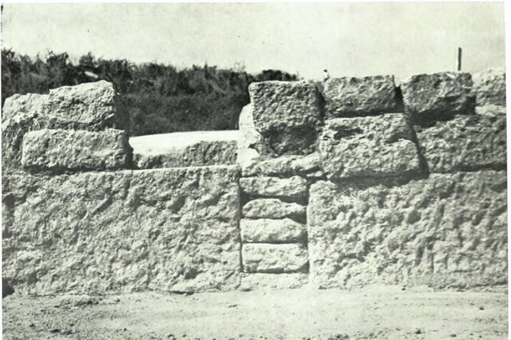
Πέλλα. Τομείς VI: α. Όχετός μετά κορινθιακῶν στρωτήρων, β. Τοιχοδομία τοῦ δωματίου Δ (τῆς δευτέρας περιόδου)
