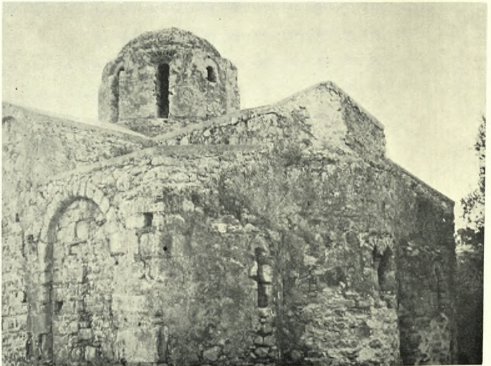
Κρήτη. Στύλος Ἀποκορώνου. Ναός Παναγίας: α. Νοτιοδυτική ὄψις πρὸ τῶν ἐργασιῶν ἀναστηλώσεως, β. Νοτιοανατολική ὄψις μετὰ τὰς ἐργασίας ἀναστηλώσεως
