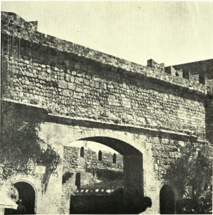
Ρόδος: α - β. Νεωτέρα "Πύλη της Ἐλευθερίας" (νοτία ὄψις) πρὸ και μετὰ τὸ πέρας τῶν ἐργασιῶν στερεώσεως τῆς ἐπιφανείας τοῦ ὑπερκειμένου τοῖχου
