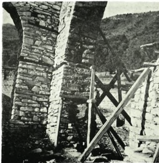
Ἰ. Μονὴ Εἰκοσιφοινίσσης Παγγαίου: α. Λεπτομέρεια τῆς στέγης πρὸ τῆς ἐπισκευῆς, β. Στέγη τοῦ ναοῦ πρὸ τῶν ἐπισκευῶν, γ. Ὁ ἀναλημματικός τοῖχος μετὰ τὴν ἐπισκευήν, δ. Ἡ στέγη μετὰ τὴν ἐπισκευήν, ε. Ἔργασια ὑποστηλώσεως κατὰ τὰς ἐργασίας συντηρήσεως
