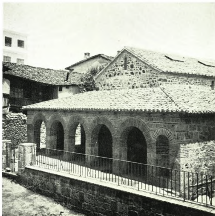
Βέροια : α. Τμήματα παλαιοχρ. θωρακίων και μαρμαροθετήματος δαπέδου ἐκ τῆς βασιλικῆς τῆς Ἀναστάσεως τοῦ Χριστοῦ (14ος αἰ.), β. Ἡ βασιλικὴ τῆς Ἀναστάσεως μετὰ τὴν ἀναστήλωσιν
