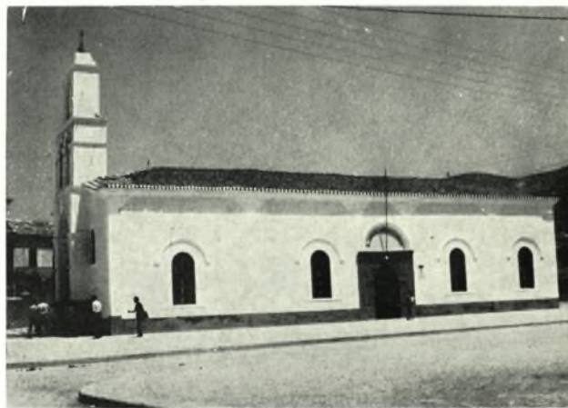
α. Εδρυτανία. Ό ναός της Ἐπισκοπῆς, β. Αἰτωλικόν. Ναός Παναγίας (Κοίμησις τῆς Θεοτόκου)
