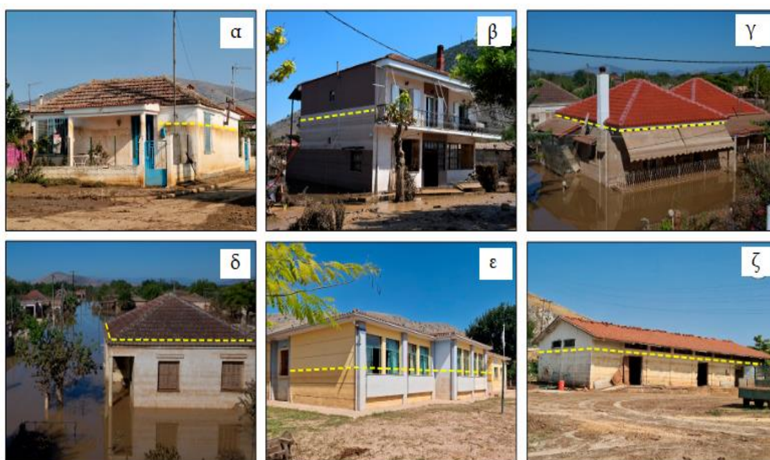
Εικόνα 3.5 Ενδεικτικές εικόνες από κτήρια μετά τη πλημμύρα στην Θεσσαλία. (α-δ) κατοικίες, (ε) σχολεία και (ζ) αποθήκες. Η διακεκομμένη κίτρινη γραμμή επισημαίνει το ανώτερο ύψος των πλημμυρικών υδάτων σε κάθε περίπτωση (τροποποιημένο από Mavroulis et al. 2024).
