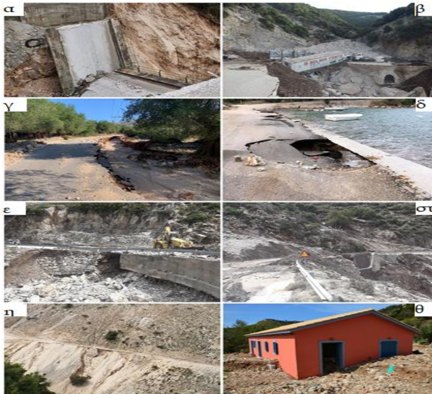
Εικόνα 3.8 Αντιπροσωπευτικές εικόνες των επιπτώσεων στις υποδομές. Περιλαμβάνουν (α-β) γέφυρες που κατέρρευσαν στην Κεφαλονιά, (γ-δ) υποσκαφές οδοστρωμάτων στην Ιθάκη, (ε-στ) κατάρρευση οδοστρωμάτων στην Κεφαλονιά, (η) καθίζηση οδοστρώματος και (θ) ζημιές σε κτίρια (τροποποιημένο από Diakakis et al. 2023).
