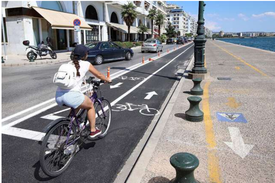
Εικόνα 4. 1 Ποδηλατοδρόμος επί του οδοστρώματος της Λεωφόρου Νίκης
