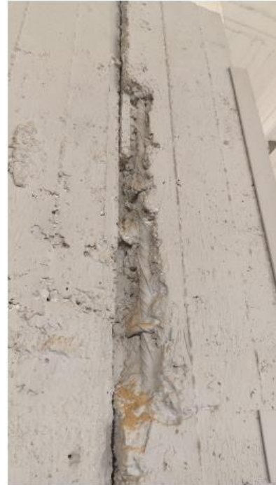
Σχήμα 2.17. Σπηλαιώση σκυροδέματος και εκτεθειμένος οπλισμός υποστυλώματος
