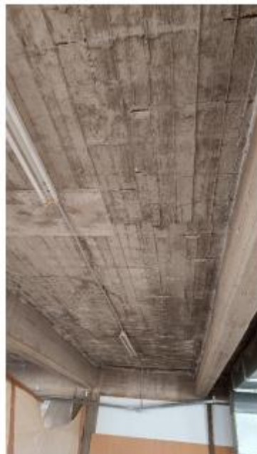
Σχήμα 2.18. Διάβρωση οπλισμού και αποκόλληση σκυροδέματος επικάλυψης πλακών 1 ου ορόφου
