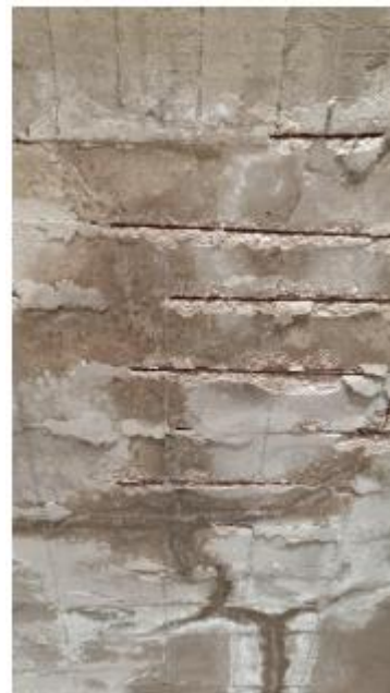
Σχήμα 2.18. Διάβρωση οπλισμού και αποκόλληση σκυροδέματος επικάλυψης πλακών 1 ου ορόφου
