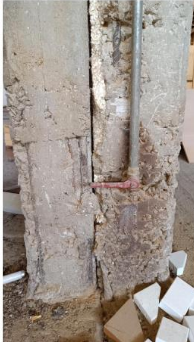
Σχήμα 2.17. Σπηλαιώση σκυροδέματος και εκτεθειμένος οπλισμός υποστυλώματος
