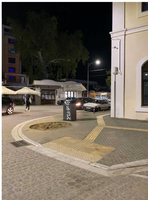
Εικόνα 39 Ράμπα και οδηγών όδευσης τυφλών στο πεζοδρόμιο
