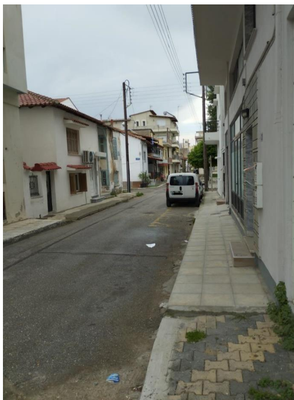
Εικόνα 36 Κακή κατάσταση πεζοδρομίου
