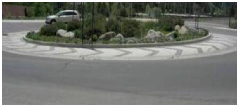
Εικόνα 14. Επίστρωση υπερβατής ζώνης δίχρωμα, σχηματίζοντας βέλη κυκλοφορίας. Πηγή: ΟΜΟΕ Κ 3 , 2012
