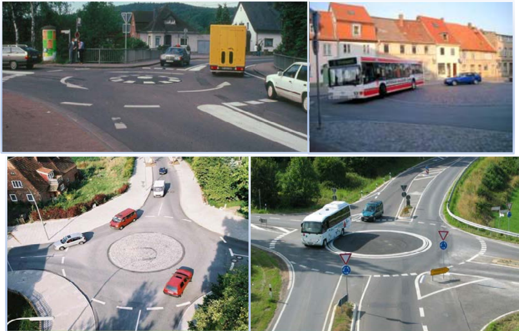
Εικόνα 4. Κομβίδια με κεντρική νησίδα πλήρως διελεύσιμη από φορτηγά. Πηγή: Brilon W., 1998
