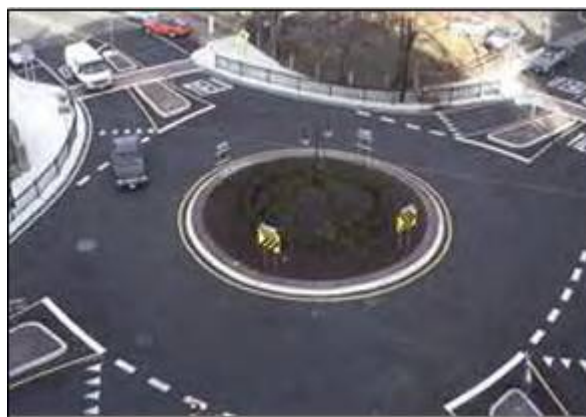
Εικόνα 6. Αστικός συνεπτυγμένος Κ3, Village of Great Neck Plaza, Νέα Υόρκη. Πηγή http://www.pedbikesafe.org
