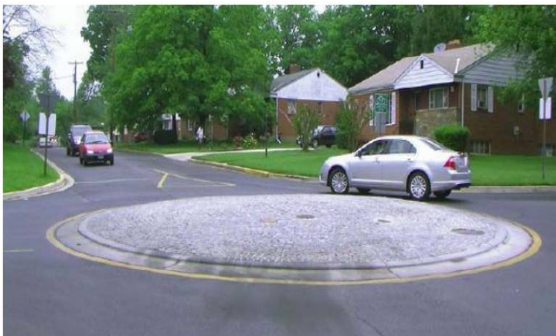
Εικόνα 5. Κομβίδιο κυκλικής κίνησης σε υφιστάμενη διασταύρωση με υπερυψωμένη κεντρική νησίδα (συνιστάται υπερύψωση max 12,5 cm στο κέντρο). Πηγή: (ΟΜΟΕ-Κ3, 2012)
