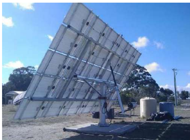
Εικόνα 3.7: Ηλιοπαρακολουθητής [11]
