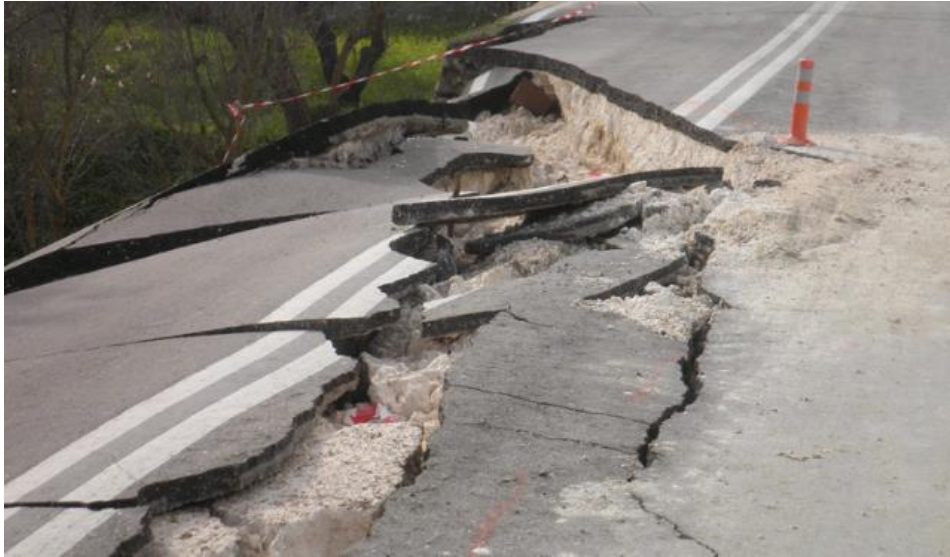
Εικόνα 2.1. Αστοχία οδικού πρανούς από σεισμό στην Κεφαλονιά το 2014 (μέγεθος 5.8 R). Πηγή: lodeproject.polimi.it
