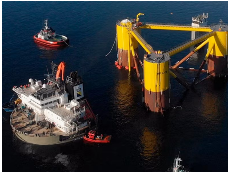
εικόνα 3.3: Η ημιβυθισμένη πλατφόρμα WindFloat, κατά την ρυμούλκησή της στην θέση εγκατάστασης( https://www.power-technology.com/ ).
