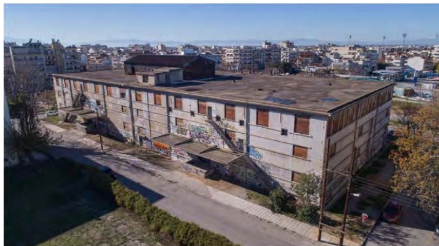
Πανοραμική άποψη του δώματος και της ανατολικής όψης. Πηγή: https://cityportal.gr/wp-content/uploads/2022/01/DSC_3142.jpg
