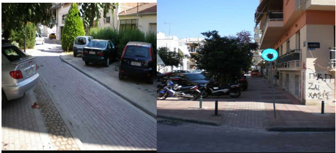
Εικόνα Error: Reference source not found.22: Ο Ποδηλατόδρομος στην Οδό Ρήγα Φεραίου σε Πεζόδρομο (Παρατηρείται η παράλληλη στάθμευσης οχημάτων η οποία δυσκολεύει τους ποδηλάτες και η φθορά της σήμανσης), Πηγή: Podhlates.gr
