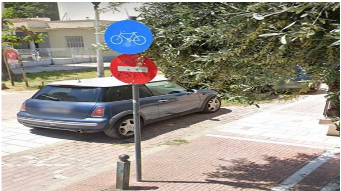
Εικόνα Error: Reference source not found.24: Ο Ποδηλατόδρομος στην Οδό Ρήγα Φεραίου σε Πεζόδρομο (Παρατηρείται η παράλληλη στάθμευση οχημάτων η οποία δυσκολεύει τους ποδηλάτες και η έλλειψη προστατευτικών), Πηγή: Podhlates.gr
