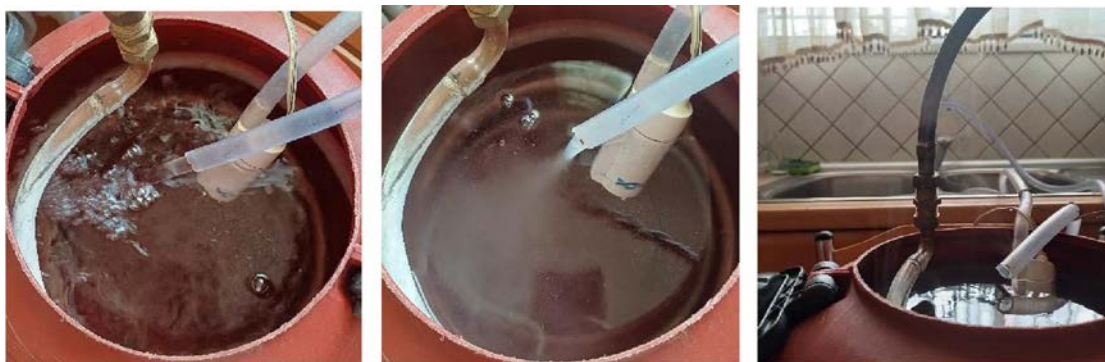
Εικόνα 28, 29 & 30: Αντικατάσταση ζεστού νερού στον ψύκτη.
