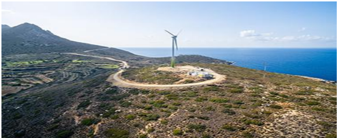
Εικόνα 4.4: S4S Project Tilos (ανεμογεννήτρια) [39]
