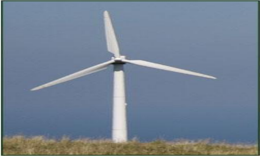
Εικόνα 3.9: Α/Γ οριζόντιου άξονα
