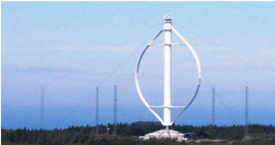
Εικόνα 3.10: Α/Γ κάθετου άξονα
