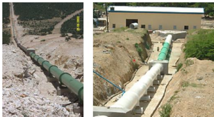
Εικόνα 3.2: Παραδείγματα αγωγών πίεσης με στηρίγματα και αγκυρώσεις
