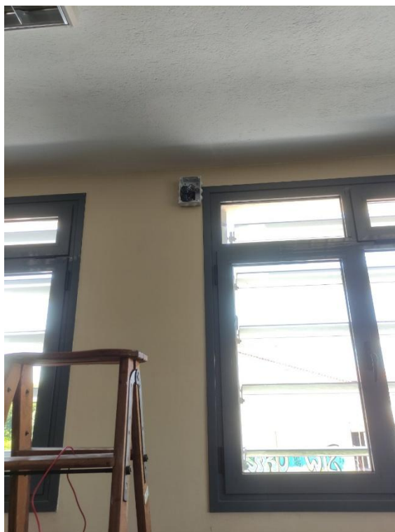
Εικόνα 11: Η τοποθέτηση των Shelly Plus 2PM των δυτικών σκιάστρων ψηλά στον τοίχο.
