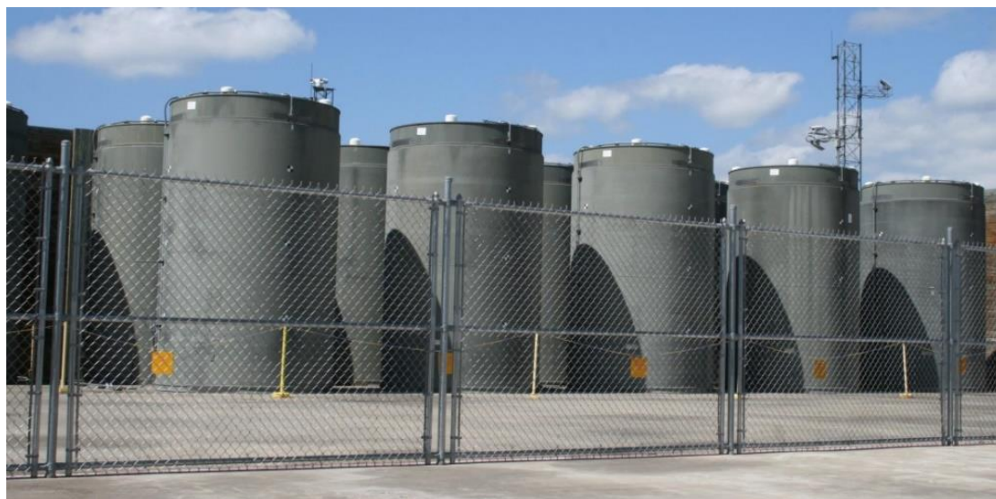
Εικόνα 14-Ειδικό κάδο ξηρής απόθεσης πυρηνικών αποβλήτων (World Nuclear Association, 2019)
