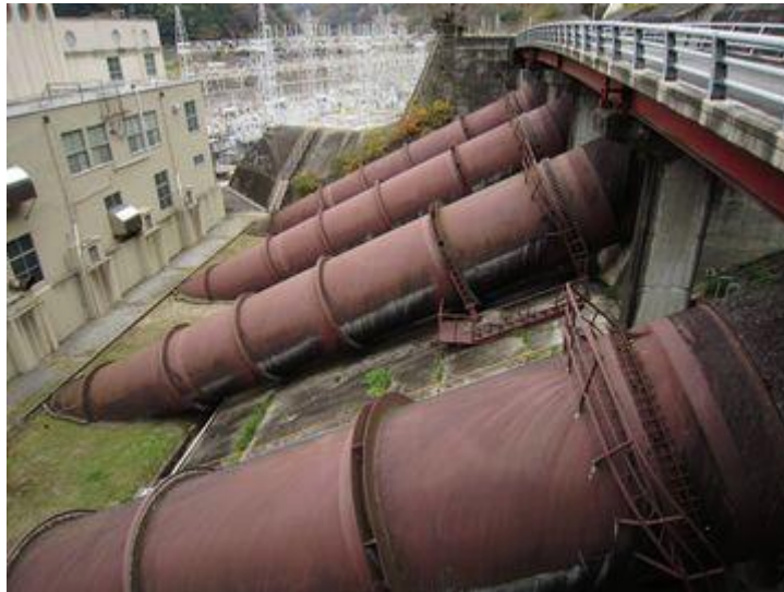
Εικόνα 2.13 Παράδειγμα υδατοφράκτη
