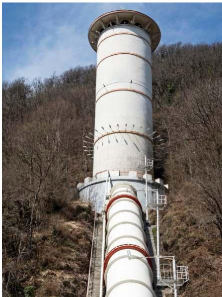
Εικόνα 2.14 (αριστερά) Παράδειγμα δοχείου υπερτάσεως
