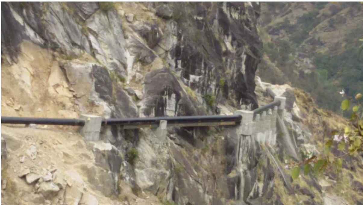
Εικόνα 4.4 Τμήμα αγωγού του σταθμού Dwari Khola
