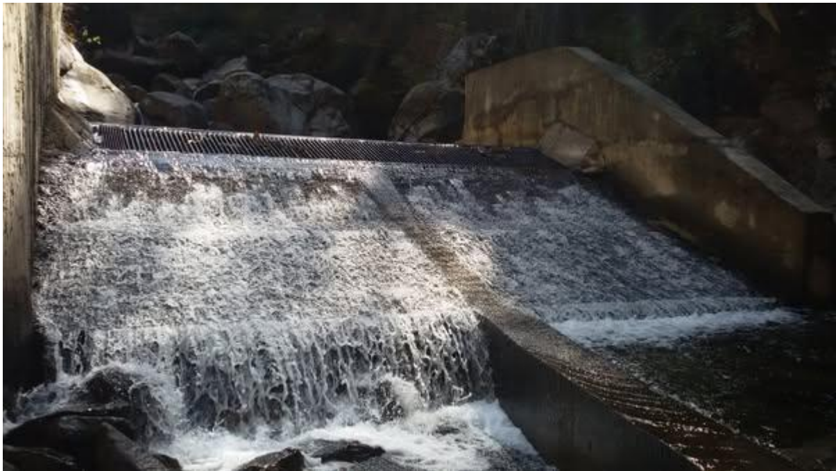
Εικόνα 4.3 Τμήμα του σταθμού Dwari Khola
