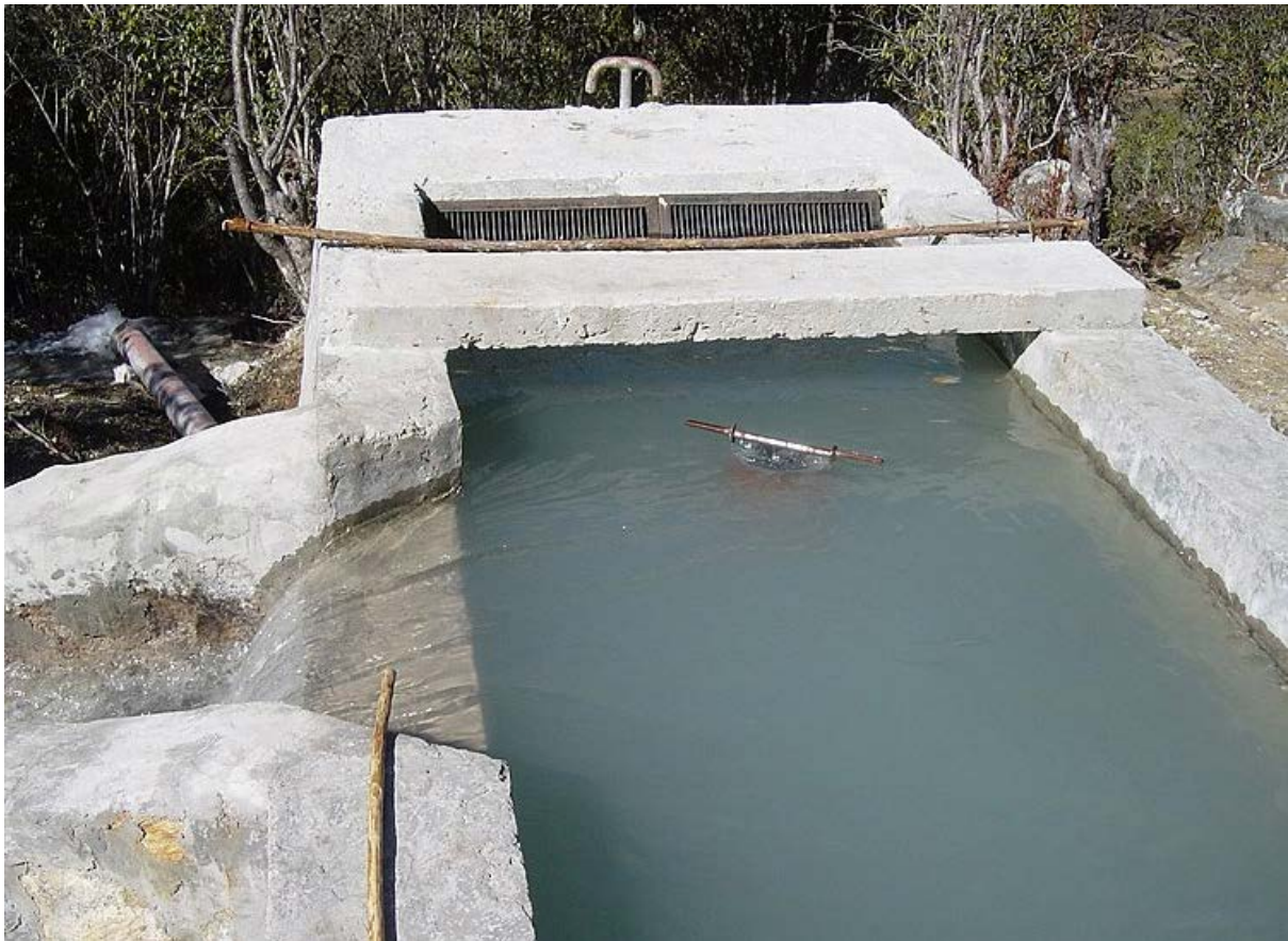
Εικόνα 2.12 Παράδειγμα δεξαμενής προβείου κόλπου
