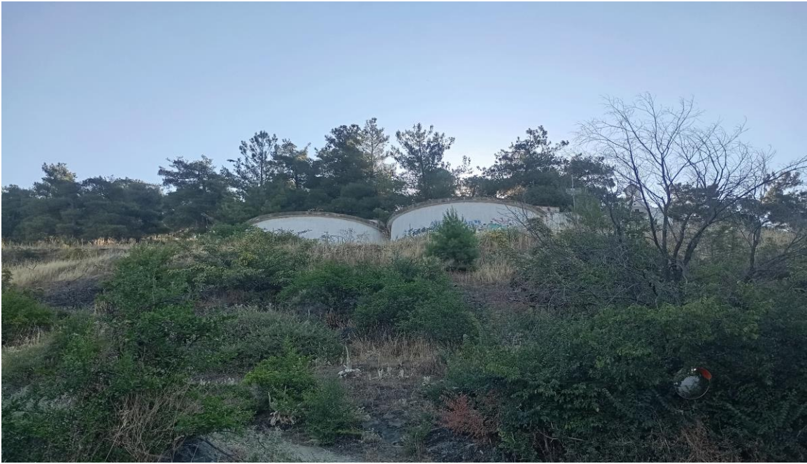
Εικόνα 4.2. Υδατοδεξαμενή ύδρευσης οικισμού Όσσης (Προσωπικό αρχείο)
