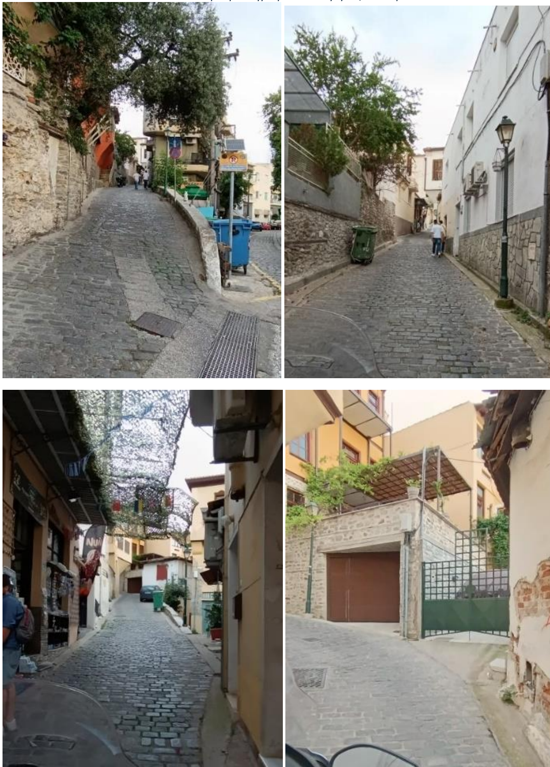
Εικόνα 30. Σειρά φωτογραφιών κατά μήκος του Τομέα 5
